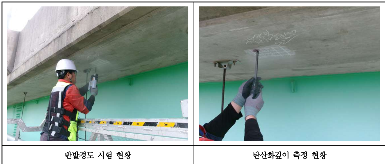
【사진 20.4.1】 콘크리트 내구성조사 현황
