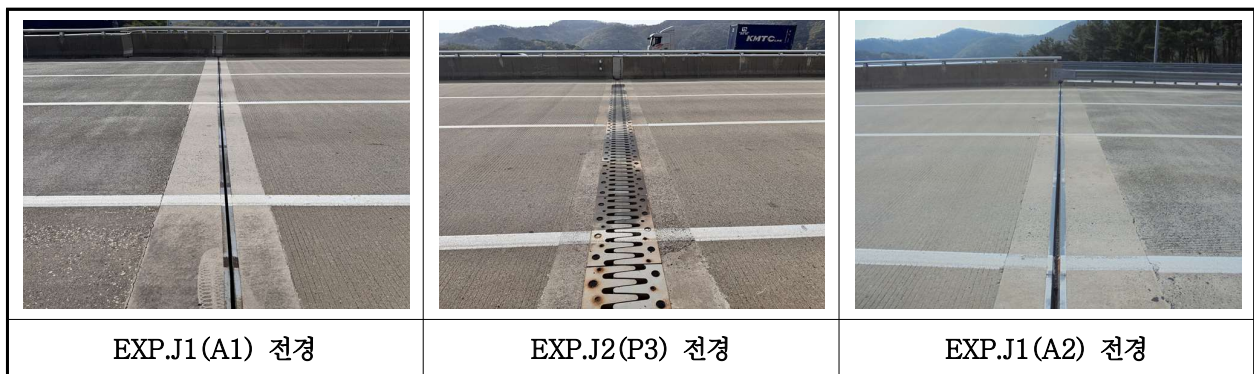
【사진 20.3.19】 신축이음장치 전경
