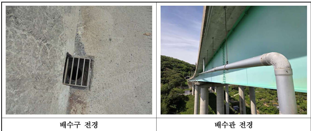
【사진 20.3.24】 배수시설 전경
