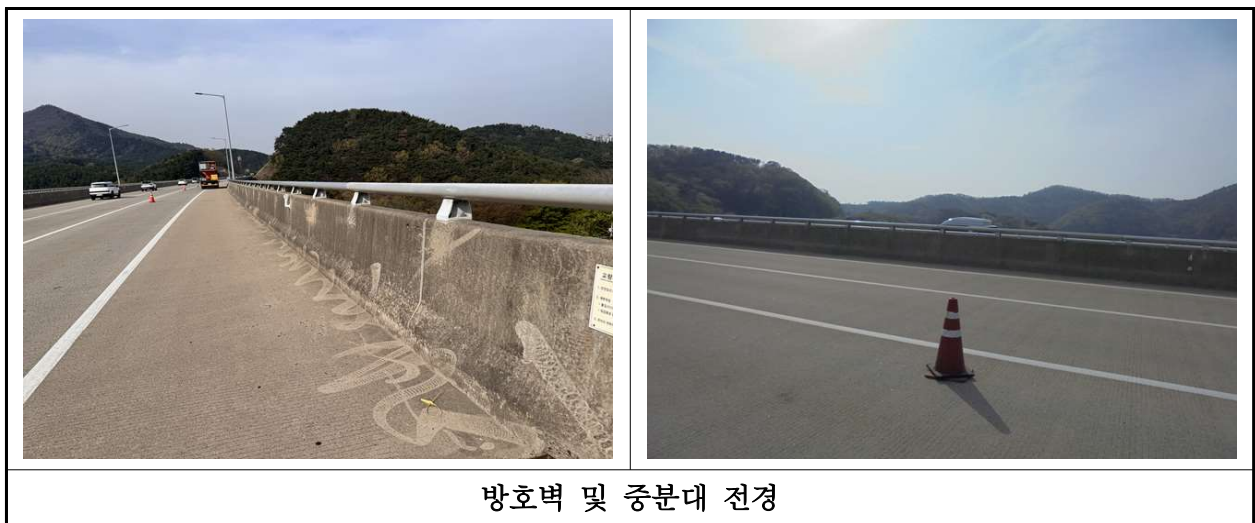
【사진 20.3.26】 방호벽 및 중분대 전경
