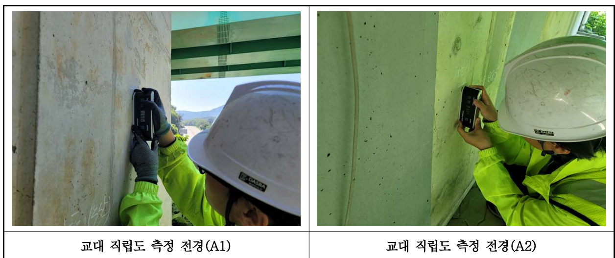
【사진 20.3.11】 교대 직립도 측정 작업사진 전경
