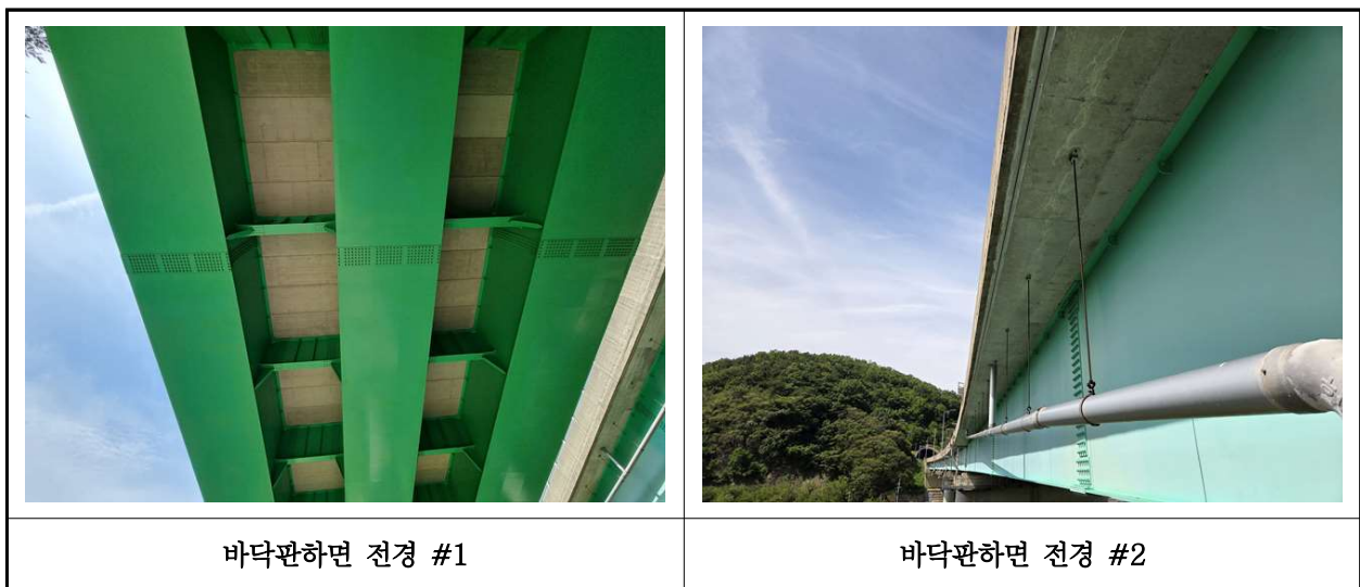
【사진 20.3.2】 바닥판하면 전경
