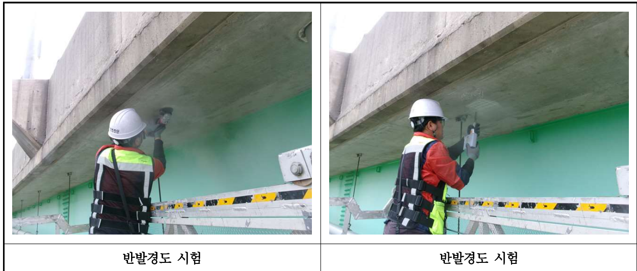
【사진 20.4.2】 반발경도시험 현장사진
