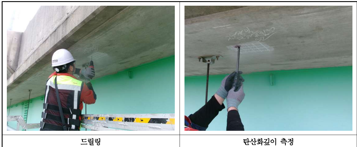
【사진 20.4.3】 탄산화 깊이 측정 현장사진
