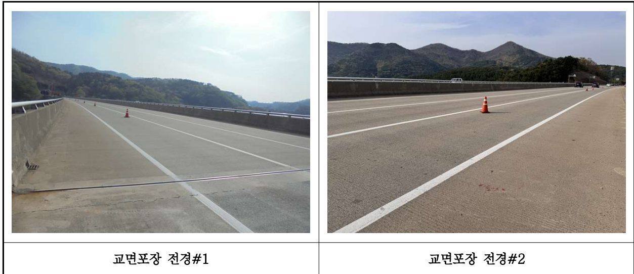
【사진 20.3.22】 교면포장 전경
