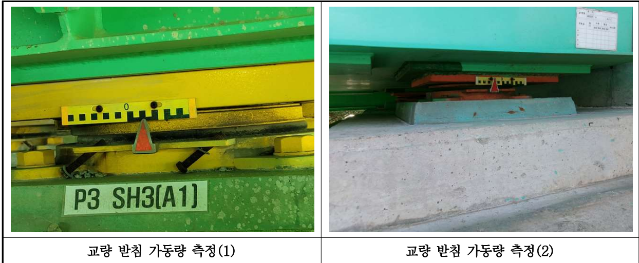
【사진 20.3.18】 교량받침 이동량 측정
